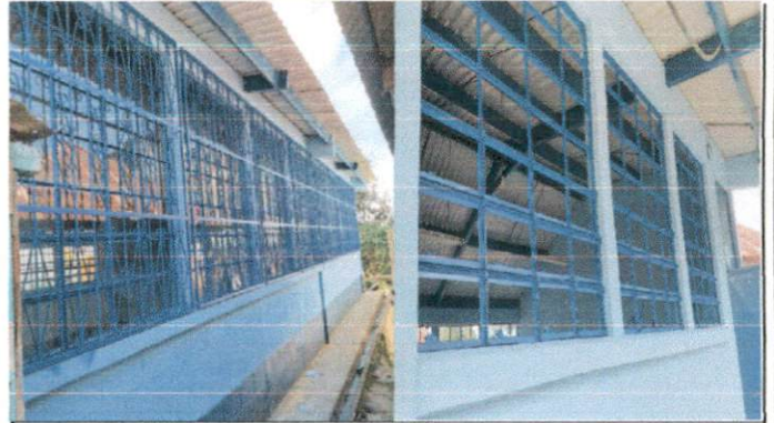
Foto 2: Sustitución de vidrios
