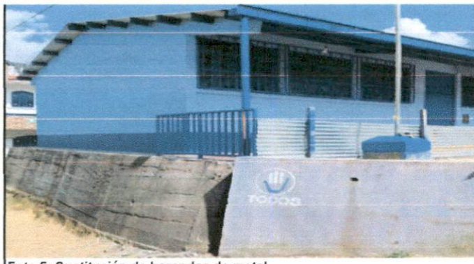
Foto 5: Sustitución de barandas de metal.
