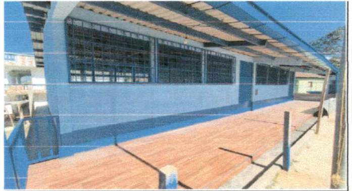
Foto 4: Sustitución de piso de granito
